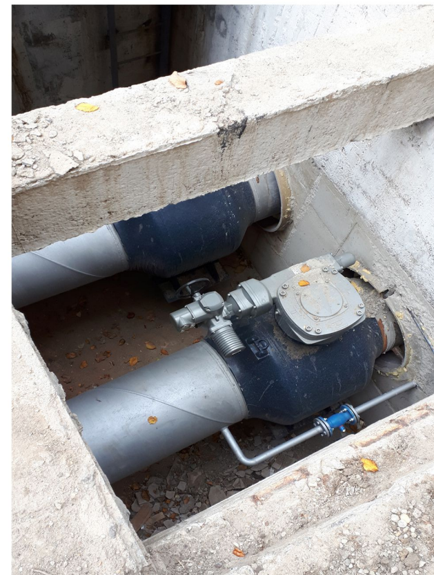
XI. Irinyi János utcát keresztező DN600-as védőcsatornás gerincvezeték felújítás
