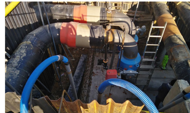
XI. Fehérvári út DN400-as védőcsatornás gerincvezeték felújítás
